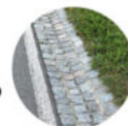
Dížděné podélné žlaby, které lze umístit i u méně propustných komunikací (komunikacích s větším spádem umožňující odtok povrchové vody do plošněho terénu či do vegetačních ploch s lepším zásokem)
