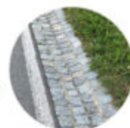
Dížděné podélné žlaby, které lze umístit v méně propustných komunikacích/komunikacích s větším spádem umožňující odtok povrchové vody do plošného terénu či do vegetačních ploch s lepším zásokem
