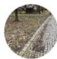
Dížděné podélné žlaby, které lze umístit v méně propustných komunikacích/komunikacích s větším spádem umožňující odtok povrchové vody do plošného terénu či do vegetačních ploch s lepším zásokem
