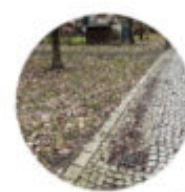
Dížděné podélné žlaby, které lze umístit i u méně propustných komunikací (komunikacích s větším spádem umožňující odtok povrchové vody do plošněho terénu či do vegetačních ploch s lepším zásokem)
