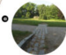
Svodnice povrchové vody na nepropustných površích. Svodnice odvedou vodu do vegetačních ploch, kde se přirozeně zadržuje.
